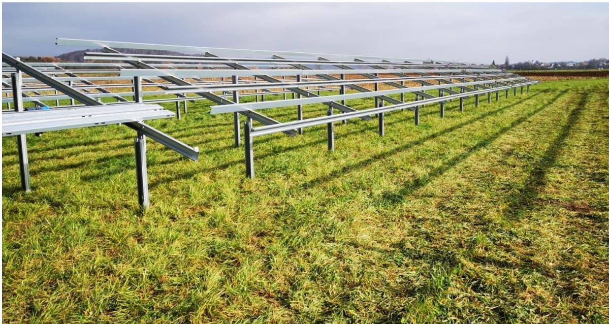
Abb. 11: in den Boden gerammte Aufständereien (Foto: Solarpark Brähle, Engen, solarcomplex AG)
